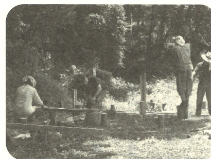
2 谷津田は湿地ですから基礎はしっかりと太い丸太杭を打ち込みました。(大変だった〜!!) その上に厚いコンクリートの基礎を固めました。
