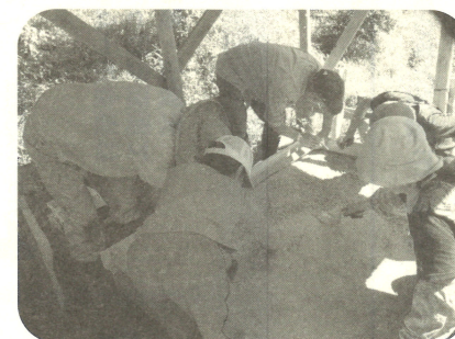
5 二段目の石窯作りの最中です。耐火コンクリートで扉の型枠や煙突部を固めています。この上に粘土やモルタルでドーム型の窯を作っていくのです。
