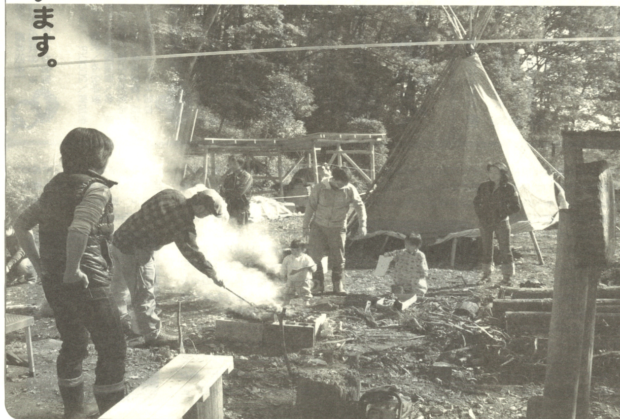
5 二段目の石窯作りの最中です。耐火コンクリートで扉の型枠や煙突部を固めています。この上に粘土やモルタルでドーム型の窯を作っていくのです。
