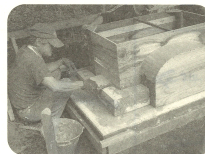
4 木製の型枠に合わせてレンガ積みです。耐火レンガを耐火モルタルで固めていきます。
