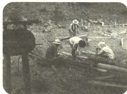
1 石窯小屋の基礎杭に防腐剤を塗ります。
